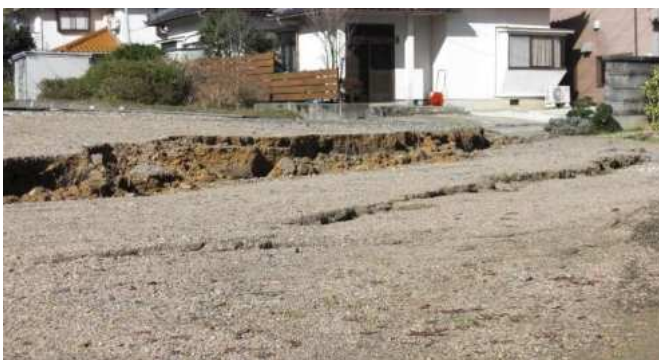
利用者宅へ向かう道路には亀裂や段差が
