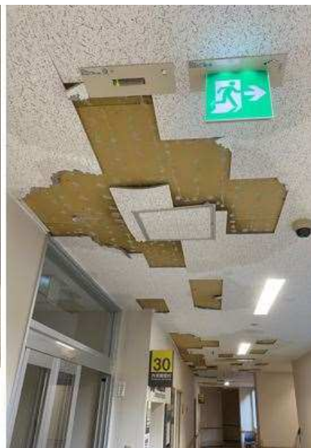
外壁の大きな亀裂や天井のボードの落下など
