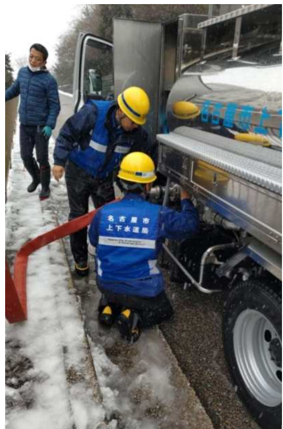
応援自治体の給水車（名古屋市）
