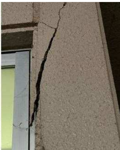
外壁の大きな亀裂や天井のボードの落下など
