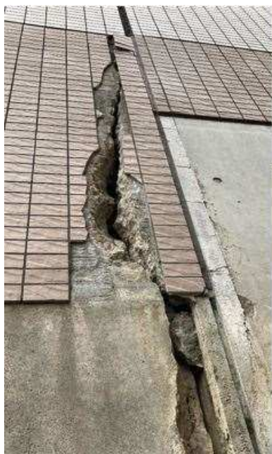
外壁の大きな亀裂や天井のボードの落下など
